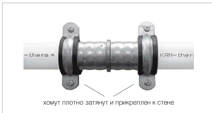
Выполнение точки неподвижной опоры рядом с удлинителем.
